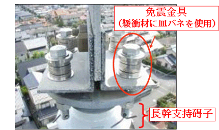
第 2. 2. 4-10 図 免震対策の施工状況
