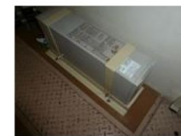
(無停電電源装置の写真)
