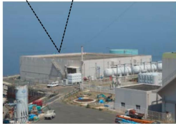
2 - 固体廃棄物貯蔵庫
