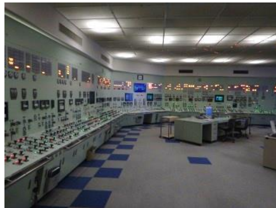
(直流非常灯点灯状態)
