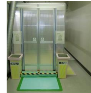
図 3.3-6 チェンジングエリアの外観
