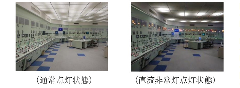
図 2.5-4 直流非常灯照明下での中央制御室のイメージ (シミュレータの点灯例)
