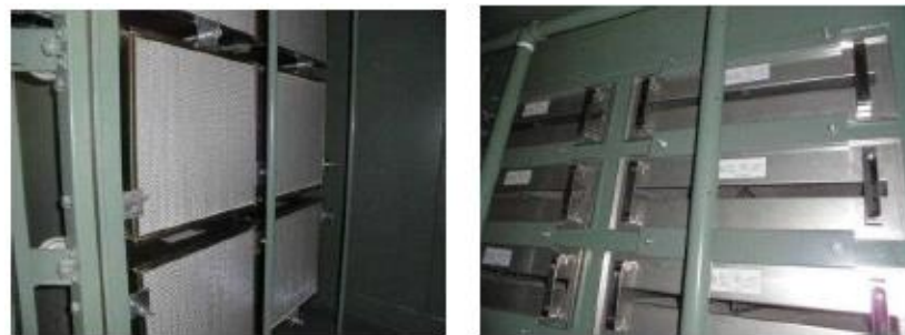
(高性能フィルタの取付け状態) (活性炭フィルタの取付け状態) 図2. 1. 4-10 再循環フィルタの取付け状態
