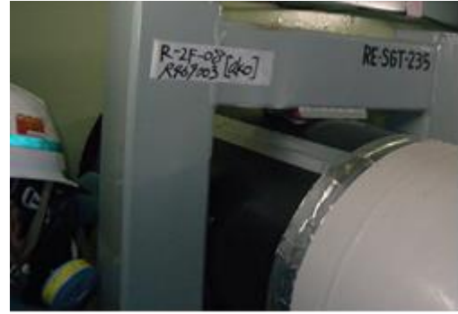
② ゴムシート貼付
