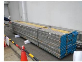
#272 足場材, 足場枠
