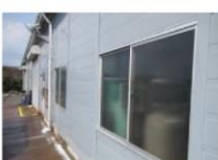
④-12 窓ガラス
