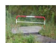
③-9 鋼製フェンス
