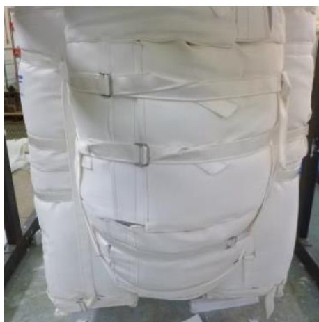
第18図 耐火ラッピングの固定状況
