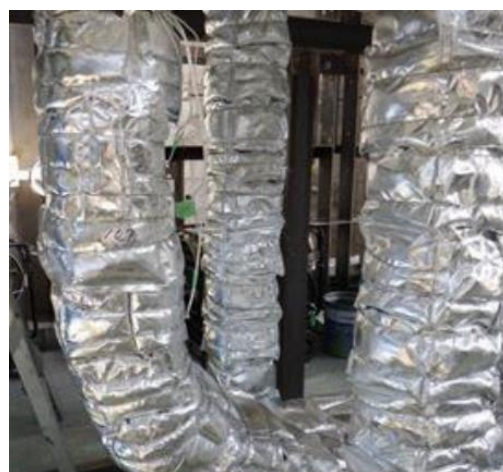
第18図 耐火ラッピングの固定状況
