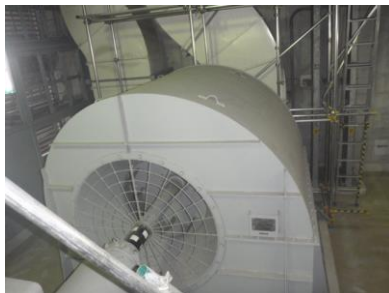
Bー非常用ディーゼル発電機室送風機及びケーブルトレイ
