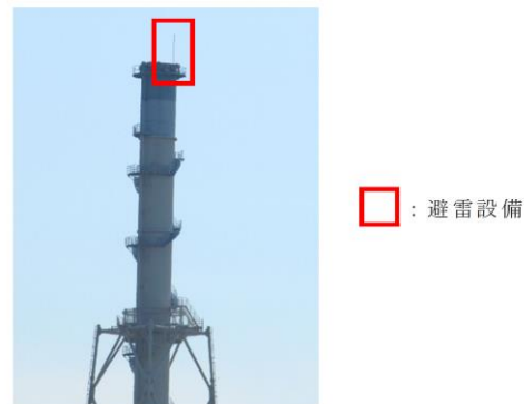
第1-16図 排気筒の避雷設備
