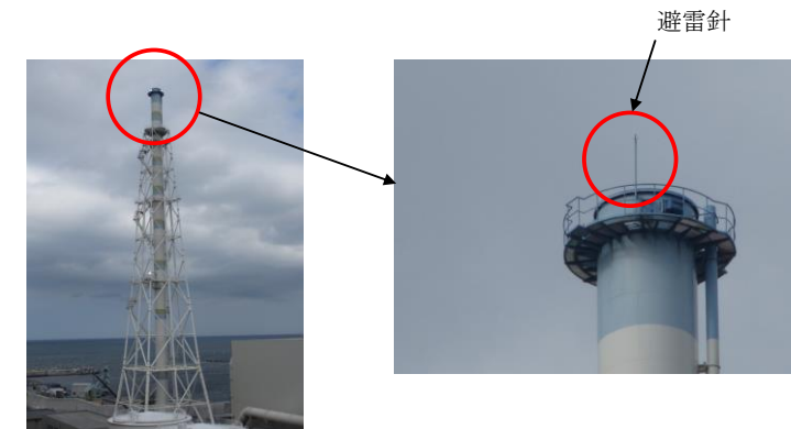
第 1-15図 避雷設備の設置例（排気筒）
