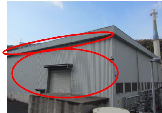
165 3号炉補助ボイラ
