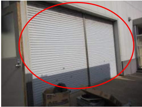
51 事務所 3 号館シャッター
