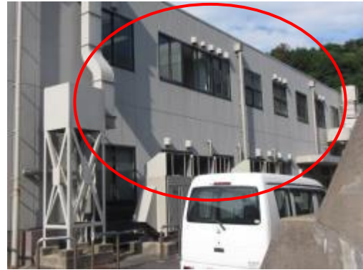
52 事務者 3 号館ガラス窓
