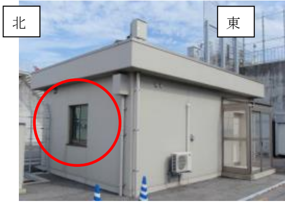
146 東口建物北側ガラス窓
