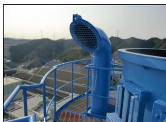
非常用ガス処理系排気管 端部状況
