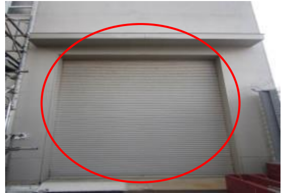
15 補機メンテナンス建物東側シャッター
