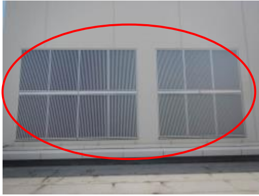
31 R w / B 空調換気系給気用格子
