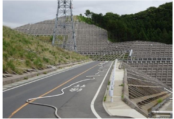
写真2 ホース展開状況
