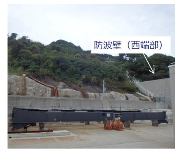
図2-21 防波壁西端部 状況写真
