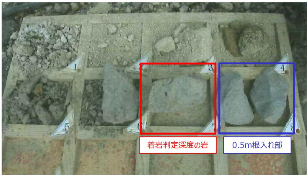
第6-30図 防波壁（逆T擁壁）支持岩盤目視確認例
