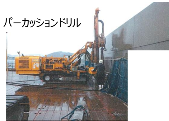
施工状況（削孔工）
