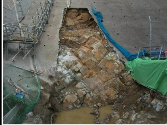
防波壁東端部 岩盤露出状況
