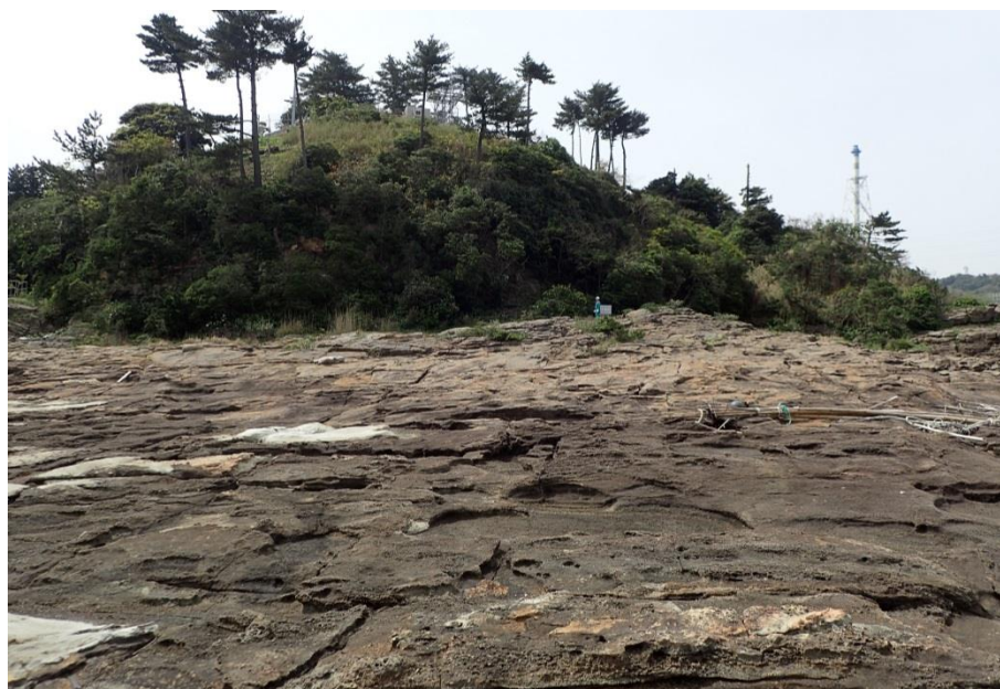
図2-8 (16) 防波壁(東端部)露頭状況 P16 地山北端部 堅硬な火山礫凝灰岩が広く露出する。
