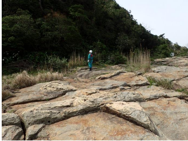
図 2 - 8 ( 1 7 ) 防波壁 ( 東端部 ) 露頭状況 P17 地山北端部 火山礫凝灰岩 C H 級
