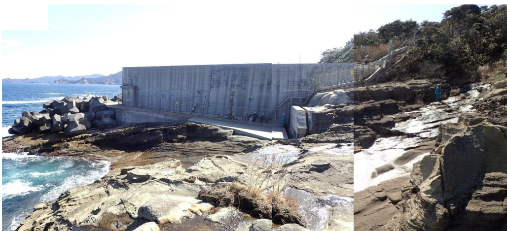
図2-41 防波壁（西端部）地山状況
