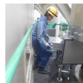
フィルタ抜取作業
