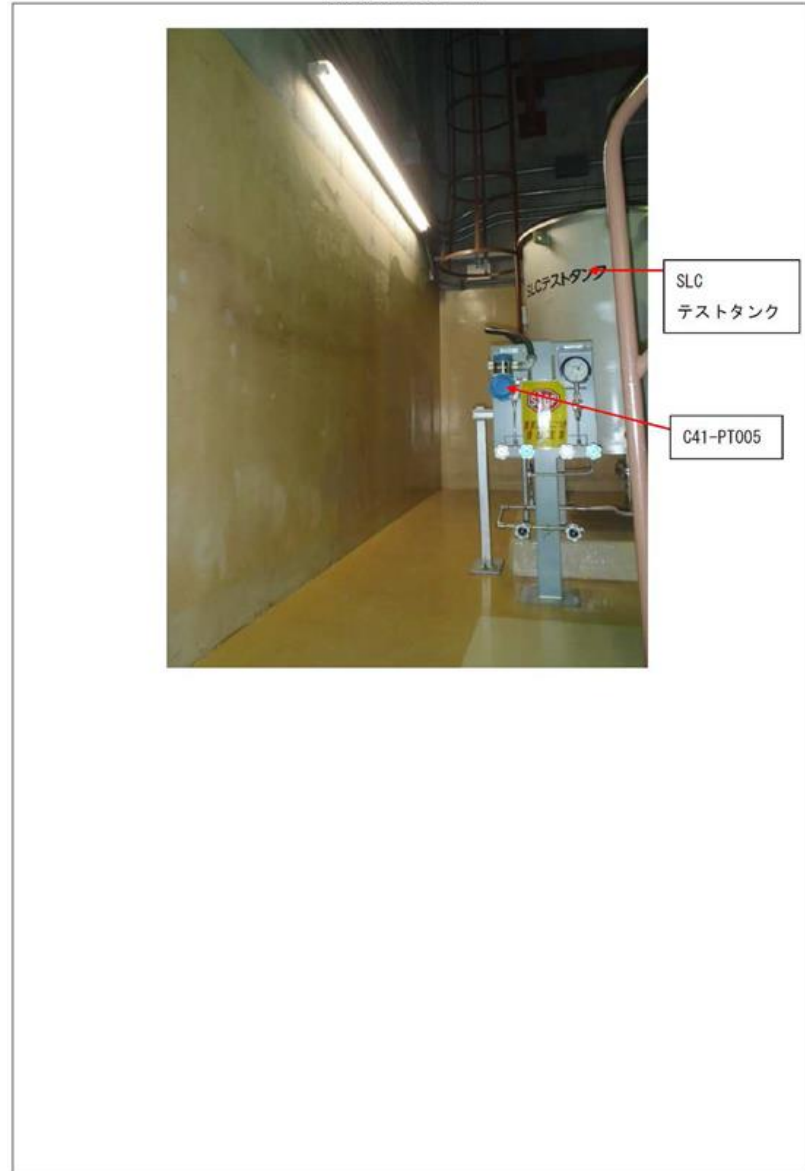
現場状況写真 等
