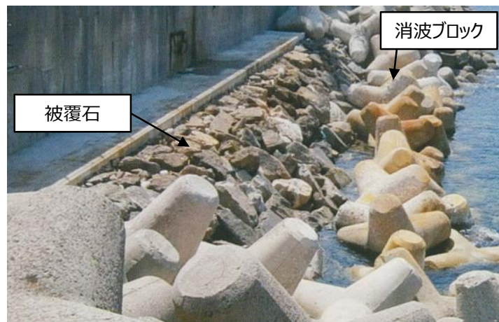
被覆石設置状況（1，2号炉北側護岸） 第2-13 図 被覆石の寸法及び設置状況
