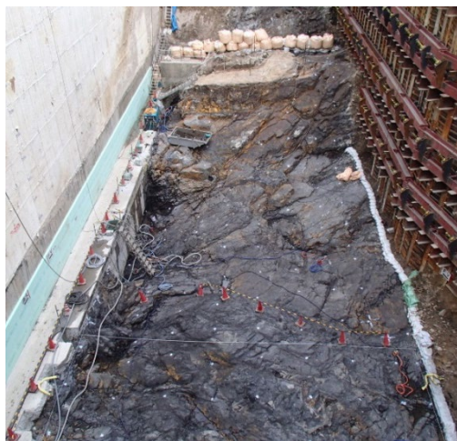
掘削面 (T. P. -5.0m)
