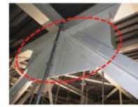
屋根トラス接合部の補強状況写真
