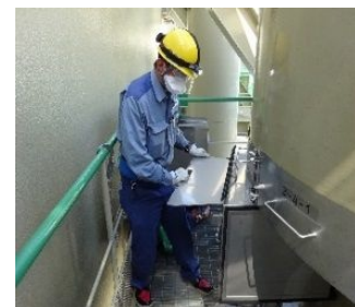
閉止板取付作業
