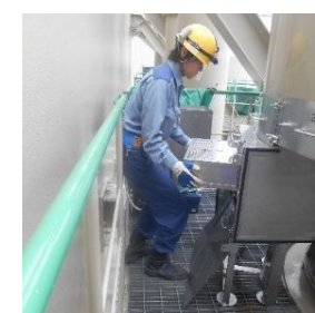
フィルタ抜取作業
