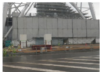
③ 試薬建屋入口から 北側を撮影
