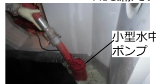
訓練の様子 (小型水中ポンプ設置)
