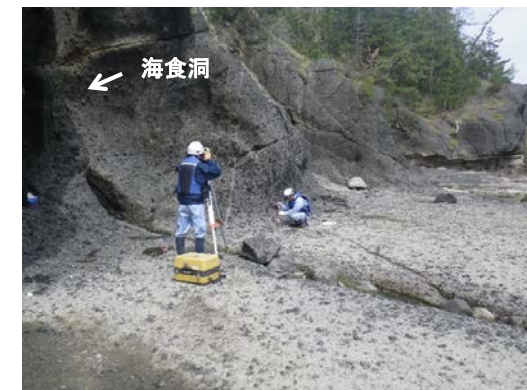
測量写真 (福浦港付近)
