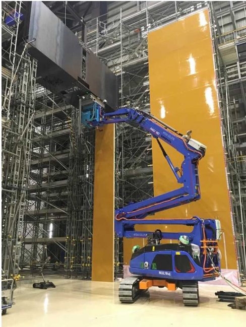
模擬天井クレーン下部除染
