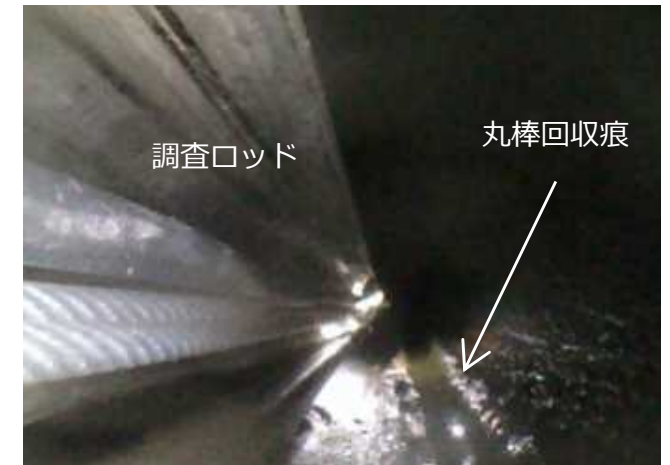
丸棒回収後のX-53ペネ内状況
