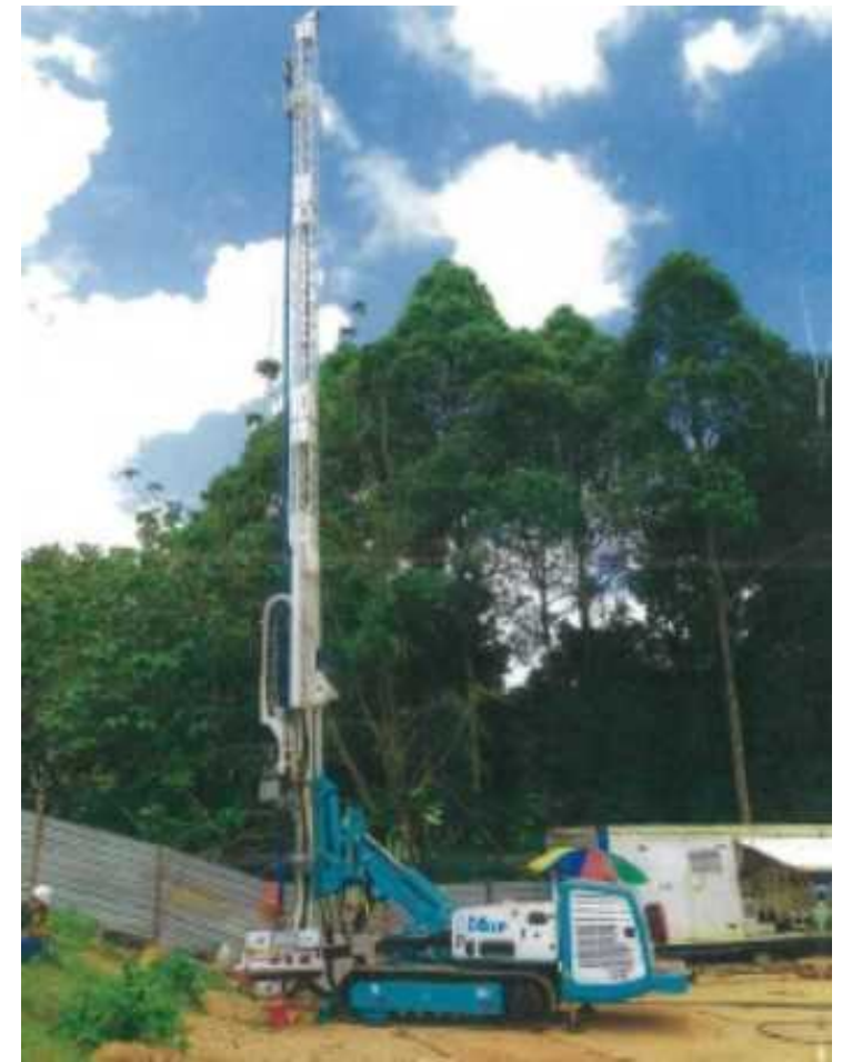
自走式地盤改良機（遠隔仕様）イメージ
