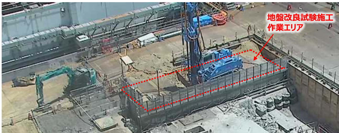
地盤改良重機配置状況
