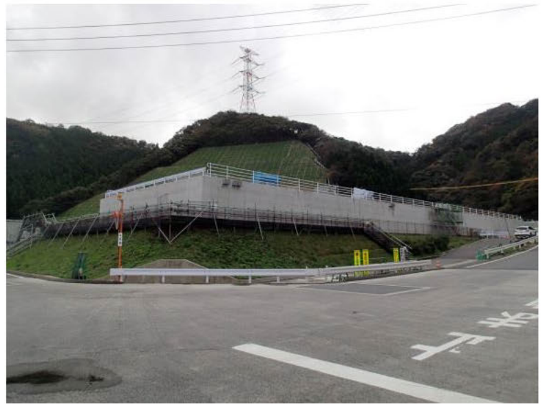
輪谷貯水槽（西 1）及び（西 2）
