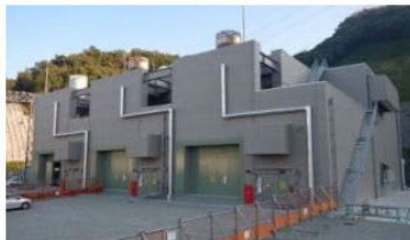
ガスタービン発電機建物 外観
