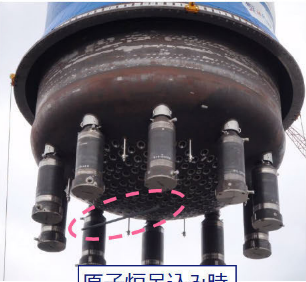
原子炉吊込み時
