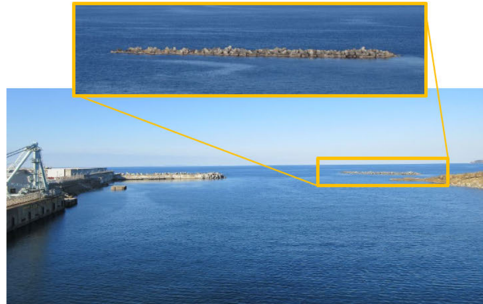
東防波堤（消波ブロック傾斜堤）写真
