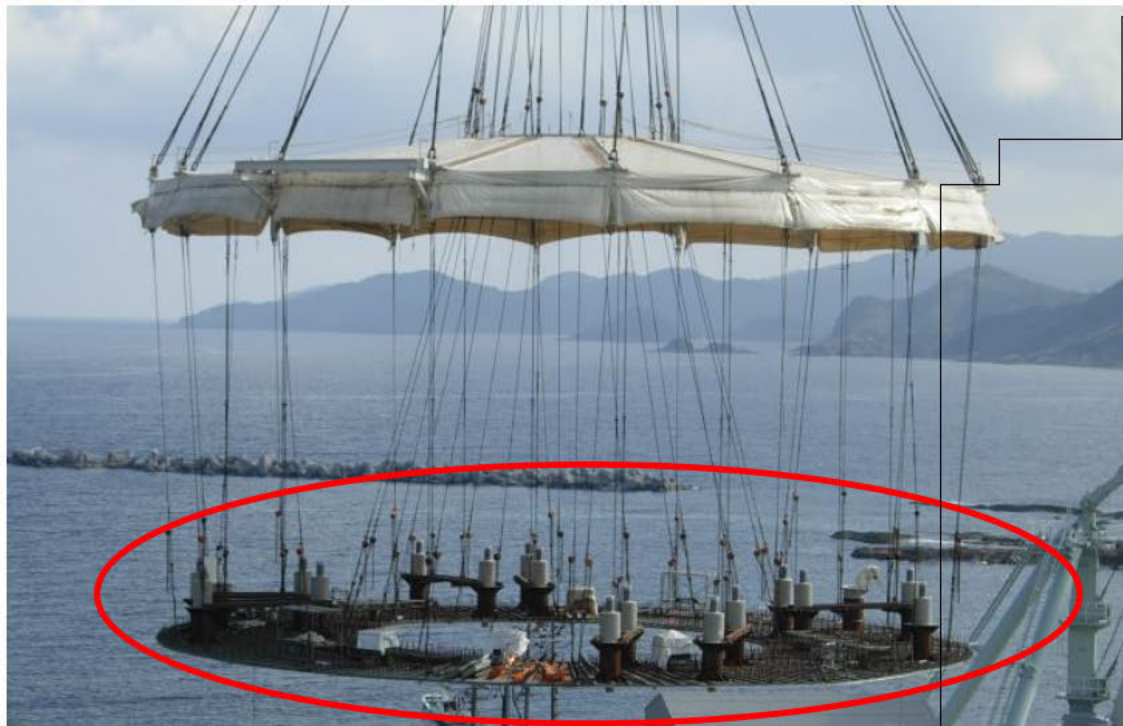
ダイヤフラムフロア吊り込み作業状況
