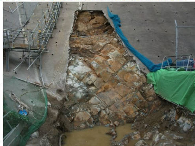
防波壁東端部 岩盤露出状況
