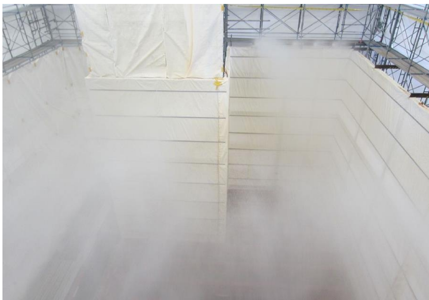
第6図 Spray時の試験状況 (Spray量 : 120m 3 /h)
