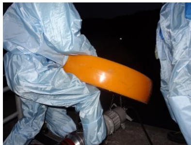
水中ポンプ設置準備（夜間）
