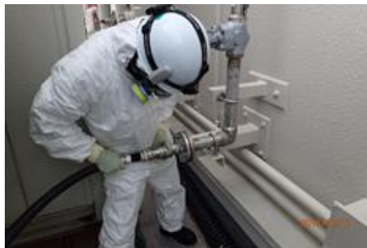
ホース接続作業
