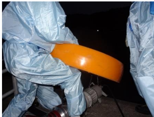
水中ポンプ設置準備（夜間）
