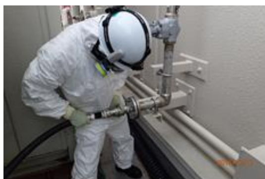
ホース接続作業
