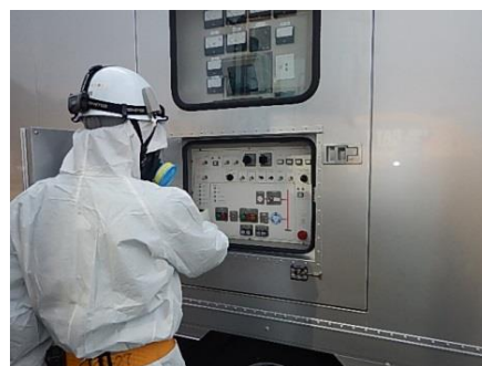
高圧発電機車での作業
