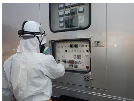
高圧発電機車での作業
