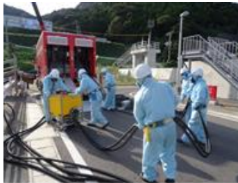
水中ポンプ設置準備（昼間）
