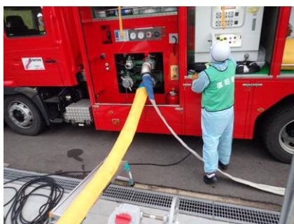
大量送水車起動
