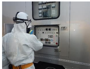
高圧発電機車での作業
