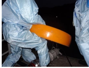
水中ポンプ設置準備（夜間）
