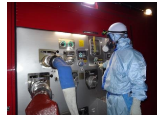
ポンプ起動操作（夜間）
