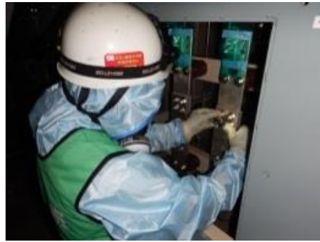
ボルトリンク接続作業
