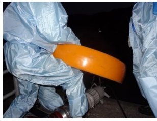
水中ポンプ設置準備(夜間)
