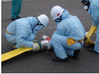
ホース接続作業（昼間）
