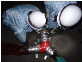
ホース接続作業（夜間）
