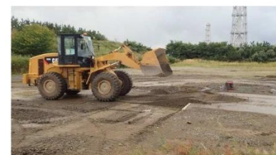
段差復旧状況③
