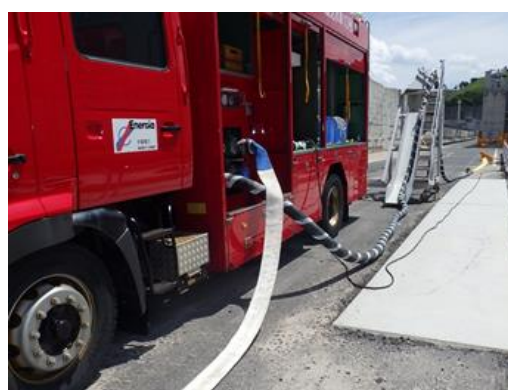
吸管・ホース・水中ポンプ設置完了後 (模擬) (E L8.5m 2号炉取水槽付近)
