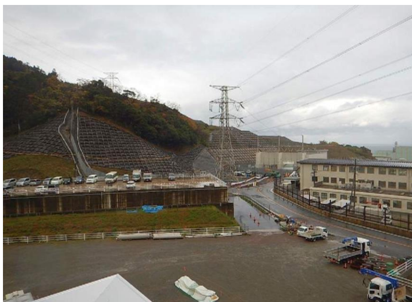
(例) 構内監視カメラ (ガスタービン発電機建物屋上) にて 輪谷貯水槽 (西1 / 西2) の北側方向
