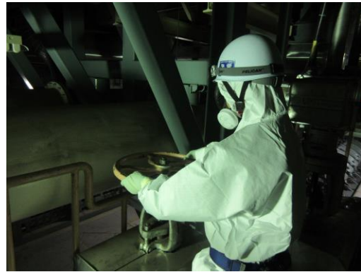
冷却水確保（系統構成）
