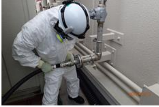
ホース接続作業
