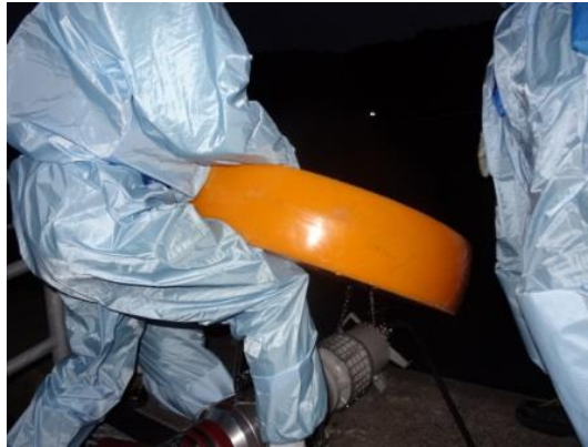
水中ポンプ設置準備（夜間）
