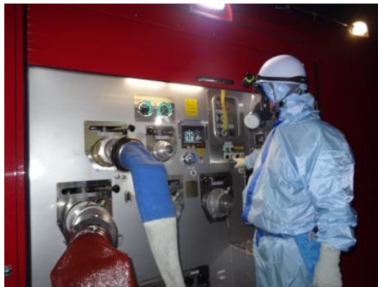
ポンプ起動操作（夜間）
