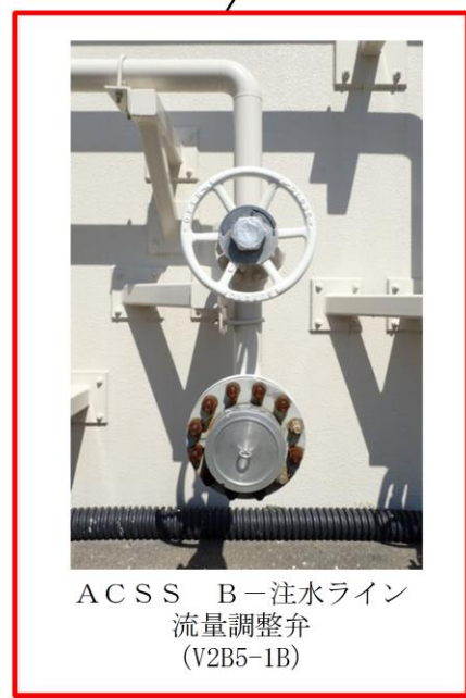
図5 格納容器代替スプレイ系に係る機器 (弁) の配置図
