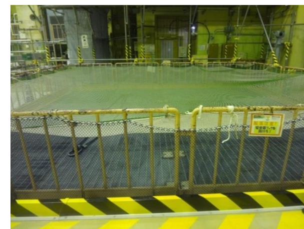
図2 大物搬入口外観
