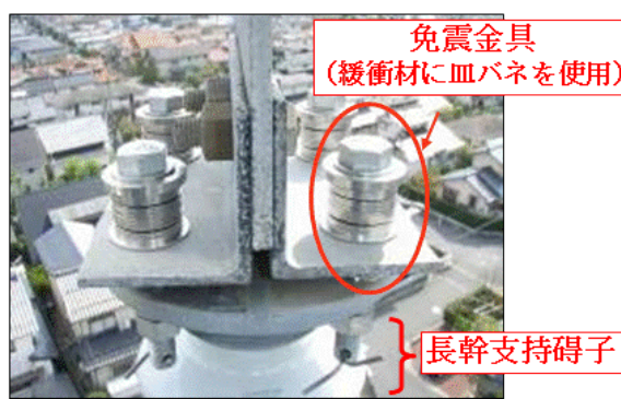
第 2. 2. 4-10 図 免震対策の施工状況
