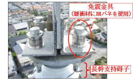
第 2. 2. 4-10 図 免震対策の施工状況
