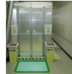
図 3.3-6 チェンジングエリアの外観
