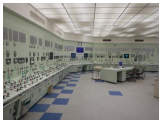
非常用照明点灯時
