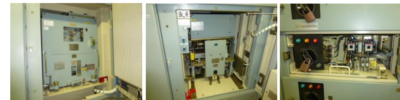
真空遮断器の例 (メタクラ)
