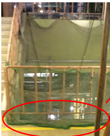
図3 想定した溢水経路に影響を与える可能性のある設備の確認例 (原子炉建物中2階)
