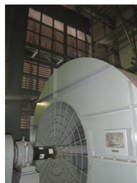
Bー非常用ディーゼル発電機室送風機及び火山灰対策（フレーム）
