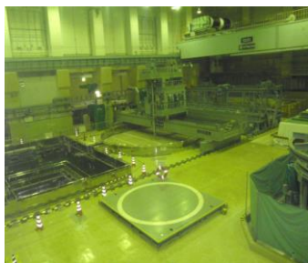
原子炉建物天井クレーン 及び燃料取替機
