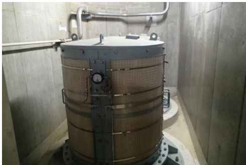
高圧炉心スプレイ系ディーゼル 発電機給気消音器フィルタ
