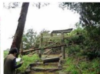
樹木の折損と鳥居の被害
