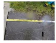
③-7 コンクリート板 (排水溝蓋)
