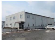
④-10 屋根, 外壁
