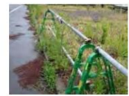
⑤-4 鋼製車止め (単管バリケード)
