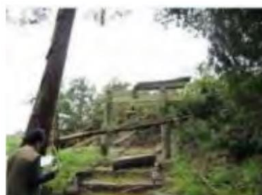
倒木の折損と鳥居の被害
