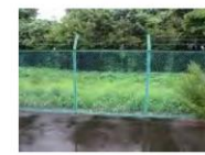
⑤-10 鋼製フェンス
