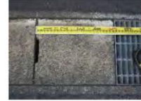
④-3 コンクリート板 (排水溝蓋)
