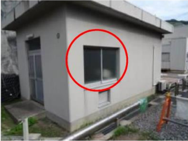
72 汚水処理施設ガラス窓
