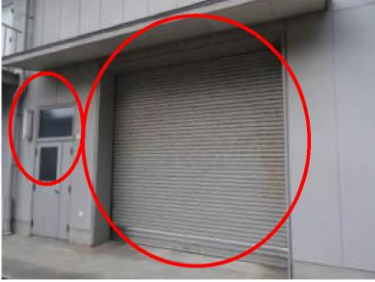
76 技術訓練棟1号館北側シャッター、ガラス窓
