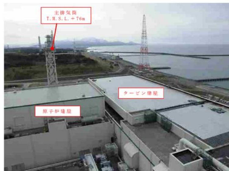
第4.3-2図 津波監視カメラ設置位置
