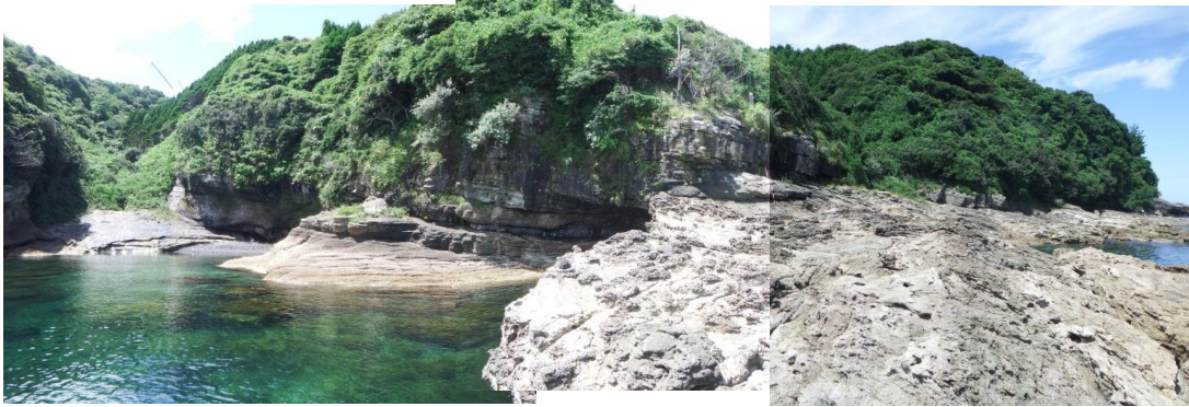
P4 海岸部には凝灰岩の連続露頭があり、層理面の走向傾斜は N57W 28N である。緩み構造の認められない C 4 級岩盤であり、地滑りの影響はないと考えられる。
