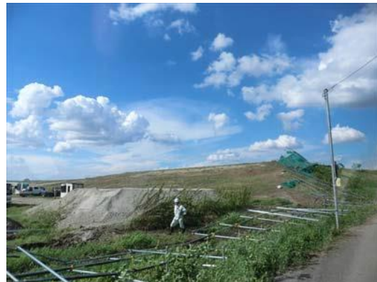
写真 5.2.20 フェンスの被害
