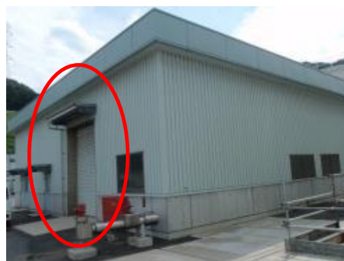
138 給水設備建物東側シャッター
