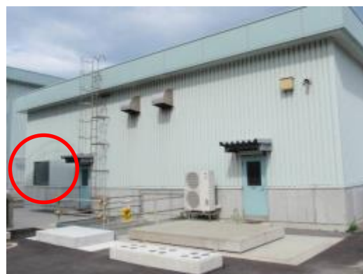
140 給水設備建物西側ガラス窓
