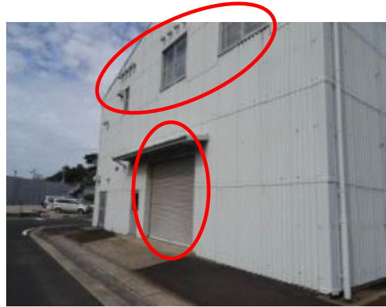
60 2号倉庫西側シャッター，ガラス窓
