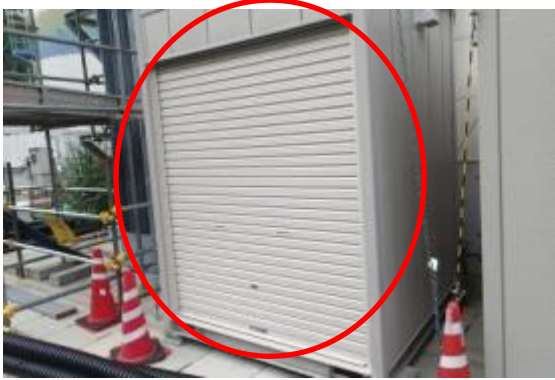
105 資材倉庫シャッター
