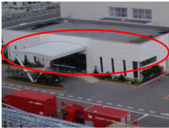
114 出入管理棟南側ガラス窓
