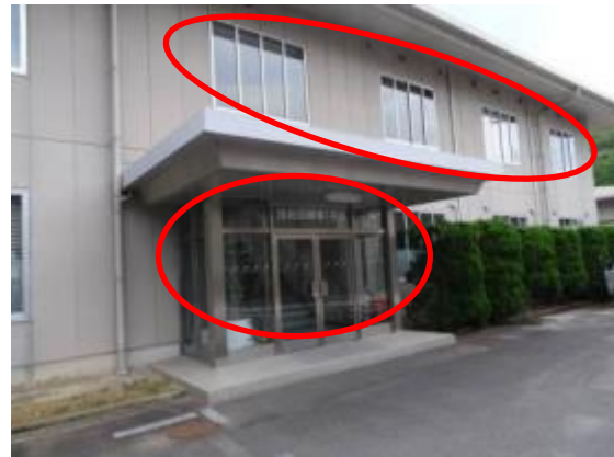
75 技術訓練棟1号館ガラス窓
