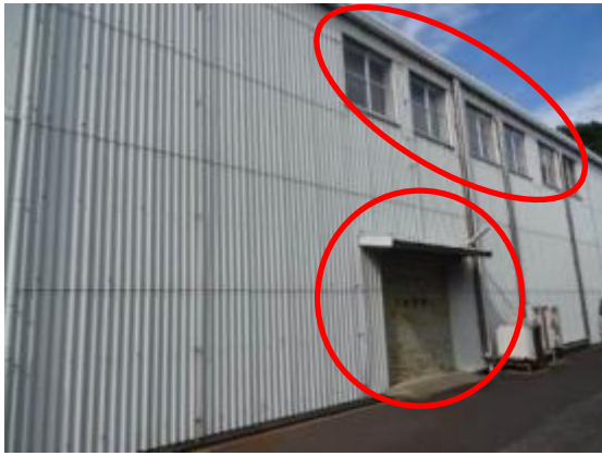
61 2号倉庫南西側シャッターガラス窓
