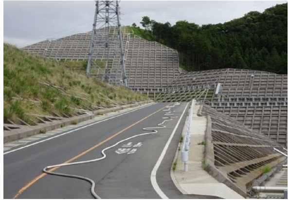
写真2 ホース展開状況
