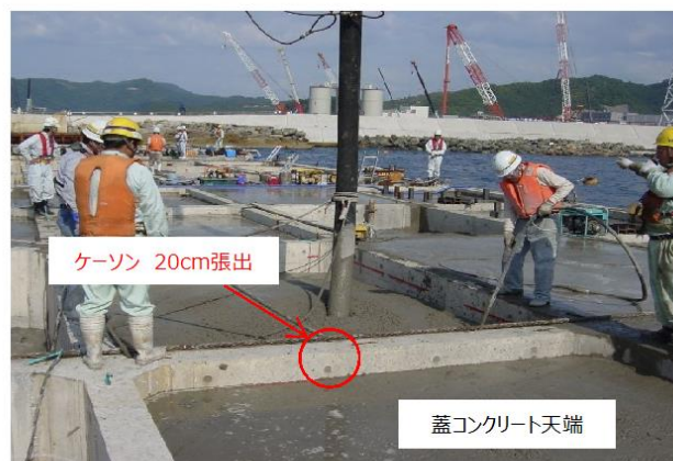
蓋コンクリート打設状況
