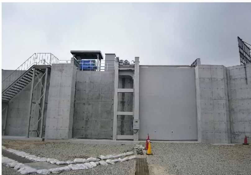
第 8-16 図 防波壁通路防波扉（1，2号炉北側）④ 設置状況
