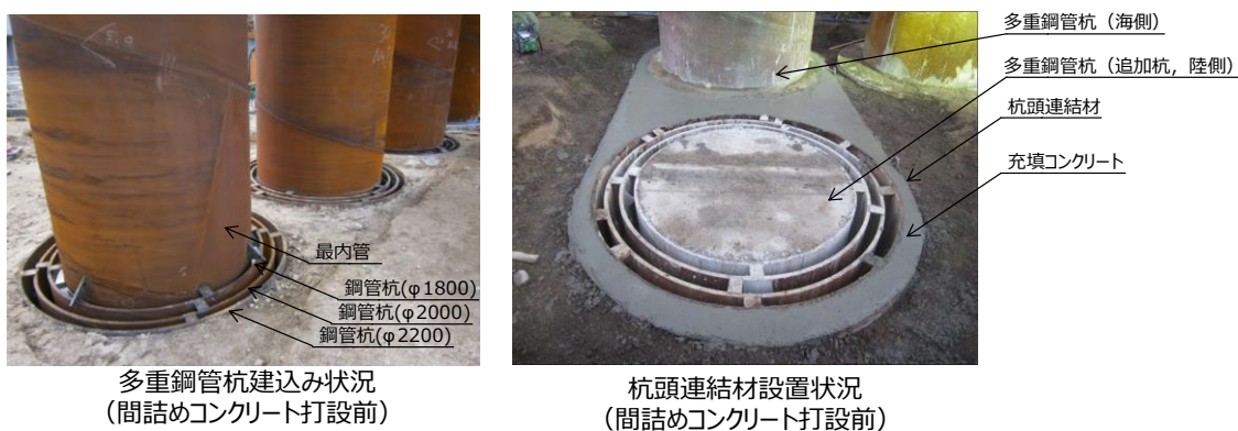
第 5-32 図 杭頭部の状況
