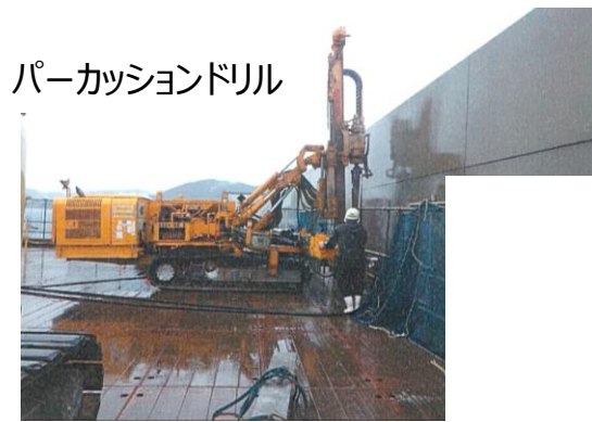
施工状況（削孔工）
