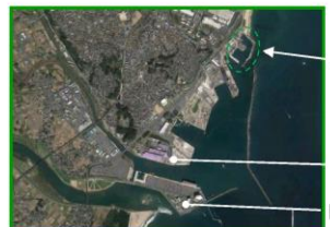
写真② 茨城港日立港区周辺状況
