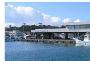
写真③ 久慈漁港状況
