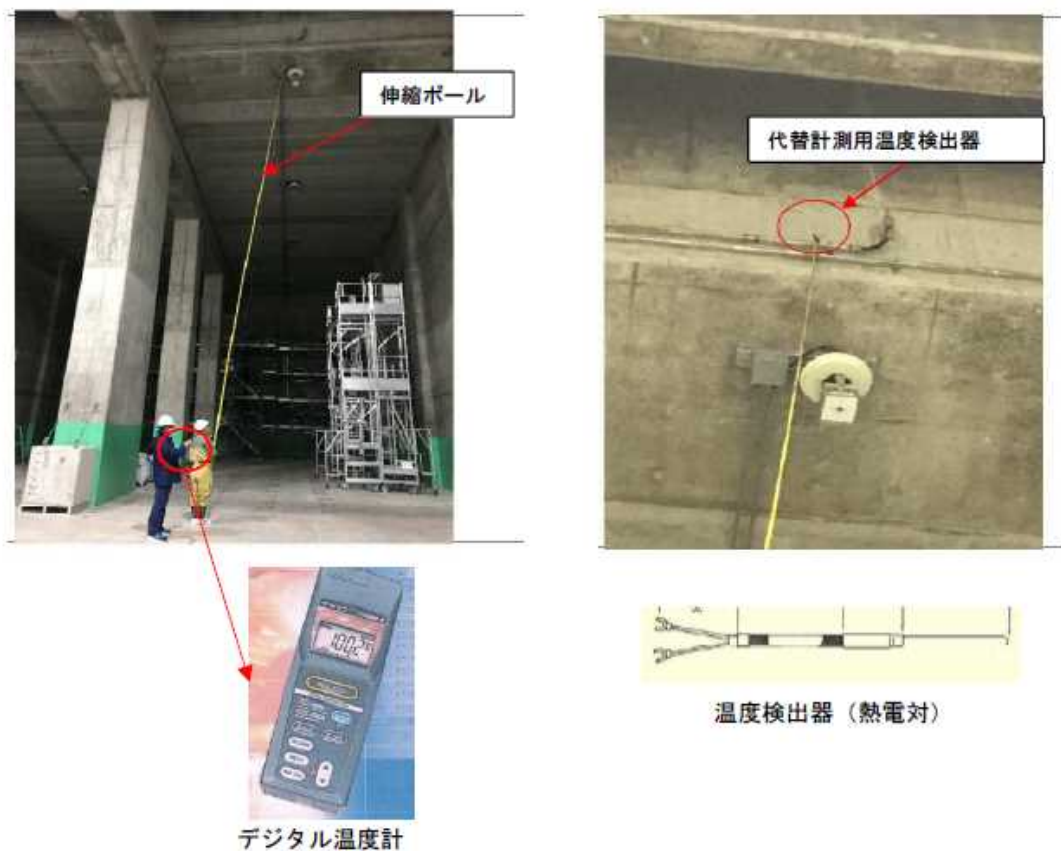
第3. 3-4図 給排気温度検出器の代替計測の計測例
